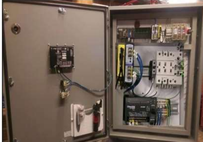
Şekil 9. Ölçüm istasyonunda kullanılan datalogger paneli 'da gösterilmektedir.
